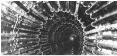
Rörpostledning i Paris avloppssystem. Public domain.
