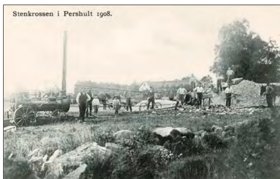
Pershults by i Småland, inte långt från Eksjö. Året är 1908 och här är man i färd med att krossa sten med en ångdriven stenkross, flankerade av ett antal storsvuxna och kraftiga män.
