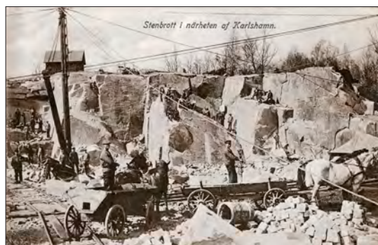
Större stenar till husgrunder, kyrkor och broar med mera bröts i stenbrott. Här ett fantastiskt kort från 1917, med arbetare i full färd med stenbrytning i ett brott nära Karlshamn.
