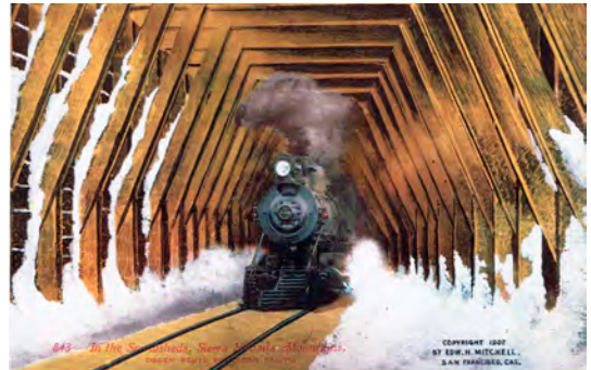
Precis som utefter vår svenska malmbana byggde man i Amerika så kallade snögallerier över spåret i de bergstrakter där laviner ofta förekom. Detta motiv är från bergen i Sierra Nevada och tryckåret är 1907.
