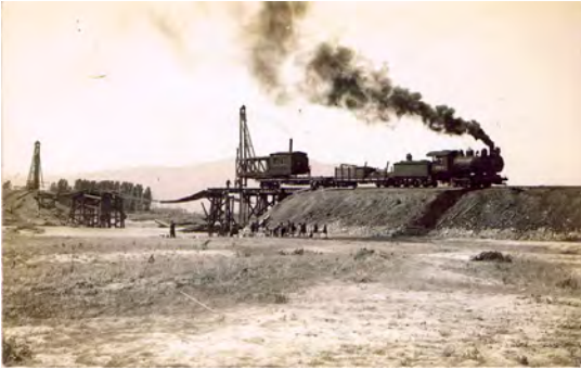
Detta fotografiska kort från cirka 1910 visar ett brobygge, och i aktern av tåget syns en stor ångdriven pålkran som driver ner de kraftiga stolparna, någonstans i Ohio. I Nordamerika var man mästare på att bygga gigantiska träbroar.
